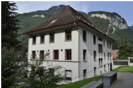
Abbildung 30: Schulanlage, Wolfenschiessen. Foto: Denkmalpflege
