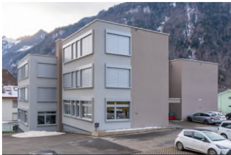
Abbildung 29: Schulanlage, Wolfenschiessen. Foto: Denkmalpflege
