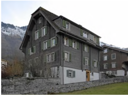
Abbildung 21: Organistenhaus, Stans. Foto: Denkmalpflege
