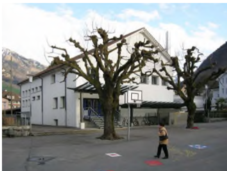
Abbildung 31: Turnhalle Tellenmatt, Stans. Foto: Denkmalpflege
