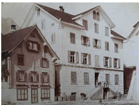
Abbildung 38: Schulhaus Dorfplatz, Beckenried (1854). Foto: Archiv Gemeinde Beckenried
